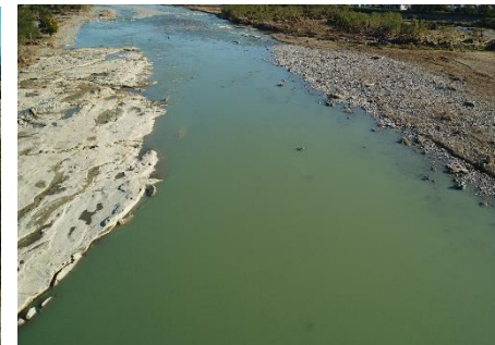
土丹層の侵食 中央線橋下流（R1.11.11撮影）
