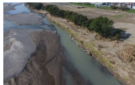
礫河原への土砂堆積 14.0k付近（R1.11.11撮影）
