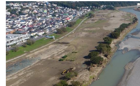
高水敷への土砂堆積 14.0k付近（R1.11.11撮影）
