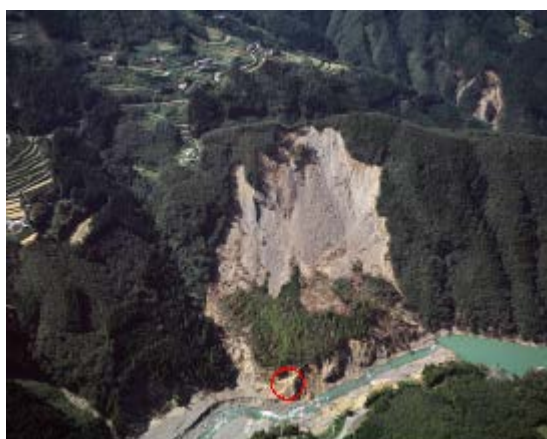
図-3 宮崎県耳川流域における野々尾天然ダム決壊後の状況
