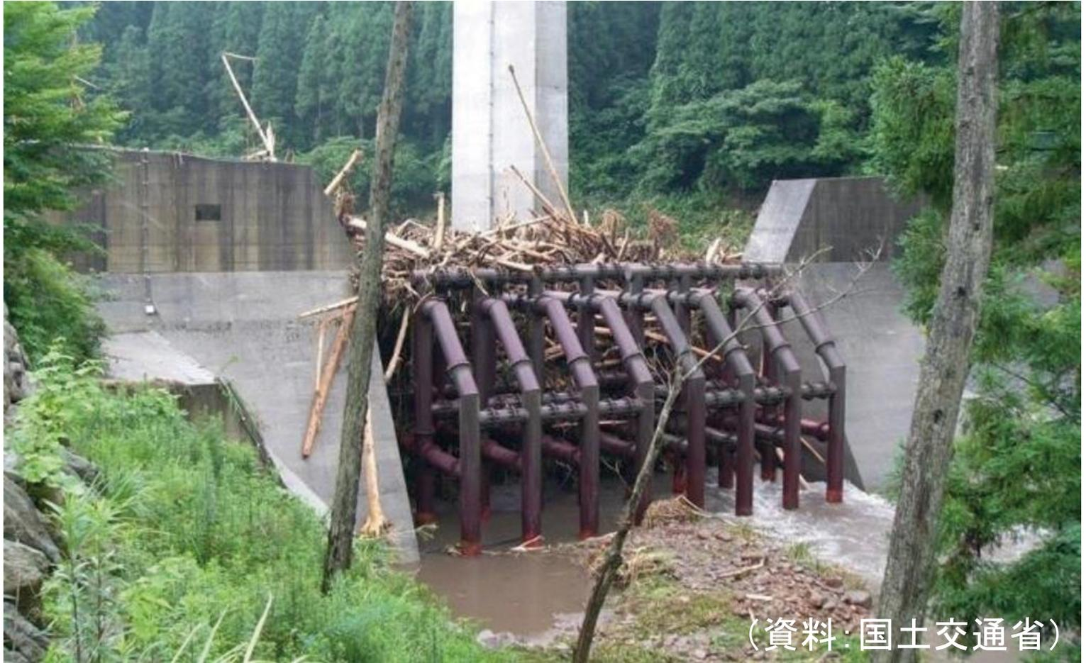
→砂防堰堤を改良して「流木止め」を増やす
