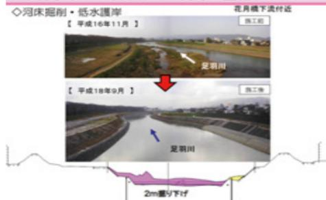
このように川底を掘削しまして、2 m程度掘削しまして川の面積を大きくすることがすでに施工されています。これが掘削前の状態で、これが完成後の状態で
