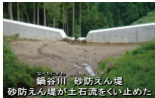
福井豪雨で砂防堰堤が土石流を止めた事例ですが、たくさんの土石流が発生しましたので全部がうまく行ったわけではないのですが、砂防ダムが、こういうふうに土石流をうまく止めた事例もいくつか報告されています。
