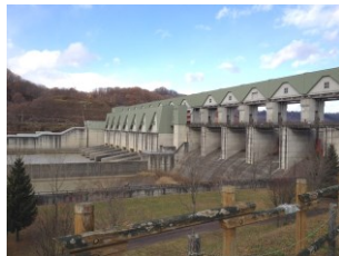
沙流川（二風谷ダム、北海道）
