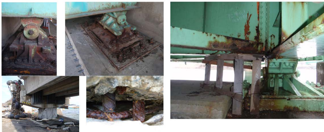
写真 6.2.1 2011 年東北地方太平洋沖地震後の被害調査中に観察された材料劣化の例
