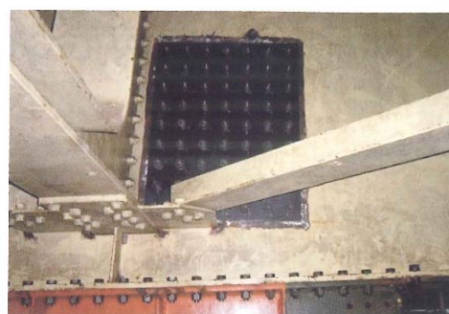
当て板(700×900×12mm) ストップホールとボルト締め用の併用
