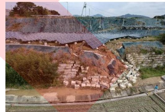
法面保護工が崩れて流出した事例
