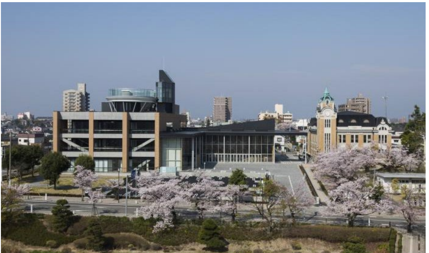
写真向かって左の建物が郡山市中央公民館・勤労青少年ホーム(同一建物内)、同右の塔のある建物が郡山公会堂
