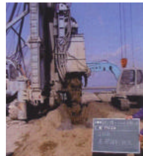
TRD施工状況
