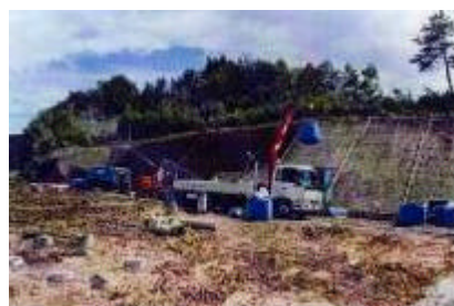
吹付け施工状況
