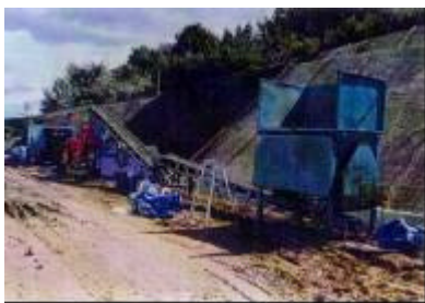
プラント設置状況
