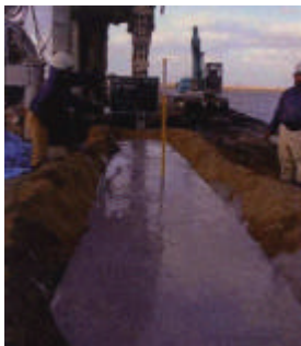
膨潤ベントナイト敷設
