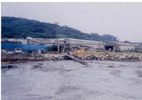
管中混合改良土吹込
