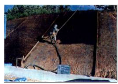
吹付け施工状況(拡大)
