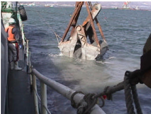
サンドマット材としての施工状況
