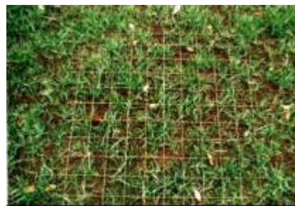
クリンカアッシュ混入吹付け材
