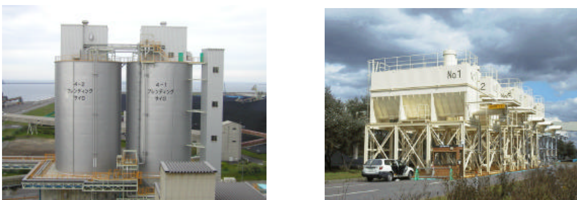
図 - 4.3.9 貯灰設備（ブレンディングサイロ及び中継サイロ）
