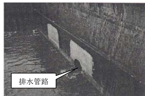
図-5.6.1.3 放水口閉塞状況 61)
