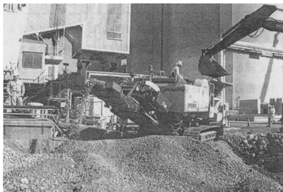
図-5.6.2.2 自走式破碎機による破碎状況 33)
