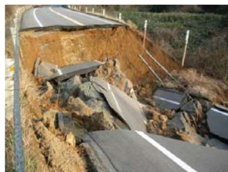
2車線の2車線崩壊
