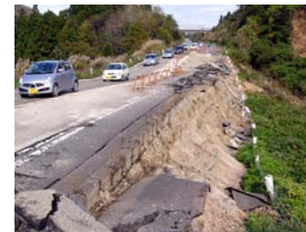
2車線の2路側・のり面崩壊
