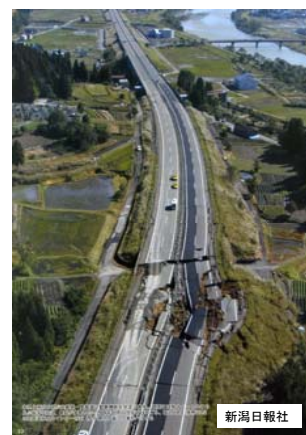
4車線の4車線崩壊
