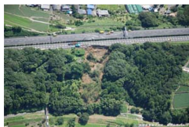
4車線のの上り1車線にかかる崩壊
