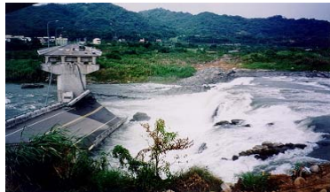
橋桁の落下および河床の段差出現
