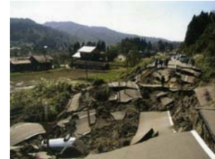
2車線の2車線崩壊
