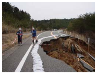
2車線の2車線にかかる崩壊
