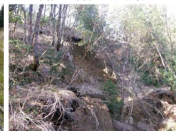
のり面内崩壊
