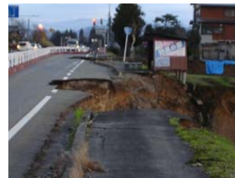
2車線の1車線崩壊:1車線通行
