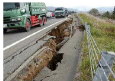
路肩のすべり:無補修のまま緊急車両走行
