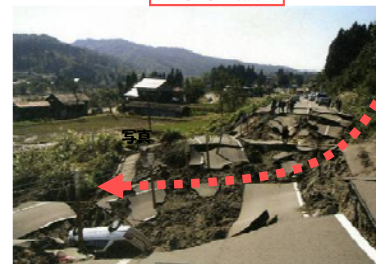
2車線に及んだすべり崩壊事例
