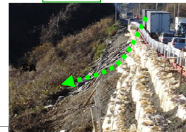
法肩付近に止まったすべり崩壊事例
