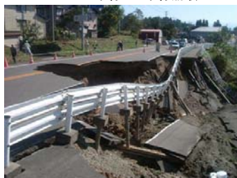
2車線の2車線にかかる崩壊
