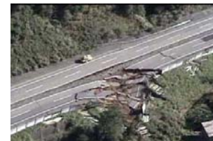
4車線のうち、2車線崩壊
