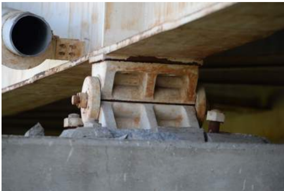
支承部ボルト破断やピン破断・脱落、上沓落下、アンカーボルト抜け出しなど、鋼製支承の様々な被害事例を確認。
