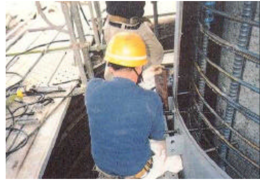
(2)鋼板型枠の設置
