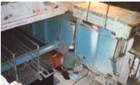
(1)主桁損傷部切断状況
