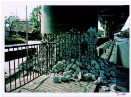
写真 4.4-1 曲げ被災の一例
