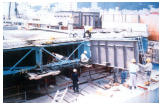
(2)損傷部取替え状況
