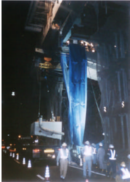
(1)桁上に設置されたテルハクレーンによる ブロック取り降し状況
