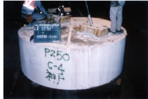
(2)ワイヤーソーイング工法により切 り出された橋脚ブロック
