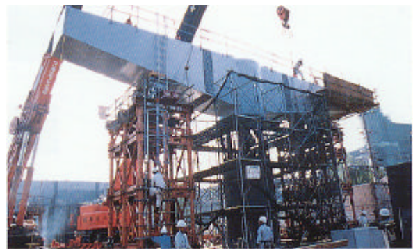
(2)鋼製梁架設状況
