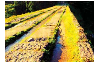
(d) 橋面上の亀裂の発生状況
