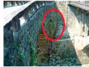
(a) 地震前右岸上流側壁石の孕み
