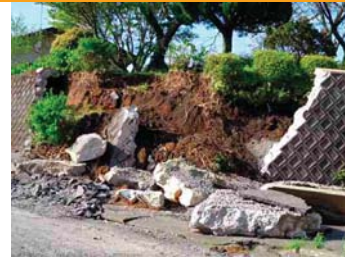
(f) 練石積擁壁の倒壊(南阿蘇村)
