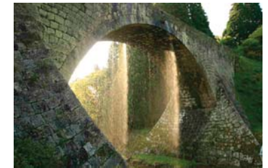
(b) 地震後のアーチ輪石からの漏水状況
