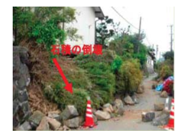
(k) 空石積擁壁の崩壊
