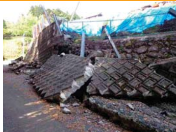
(e) 練石積擁壁の倒壊(西原町)
