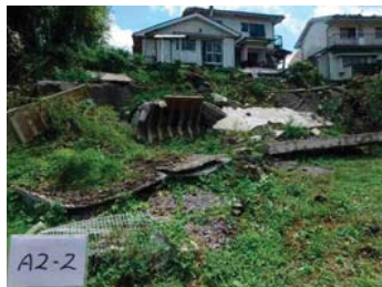
(h) L型擁壁の倒壊(南阿蘇村)
