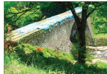
(c) 通潤橋の被災状況の全体
