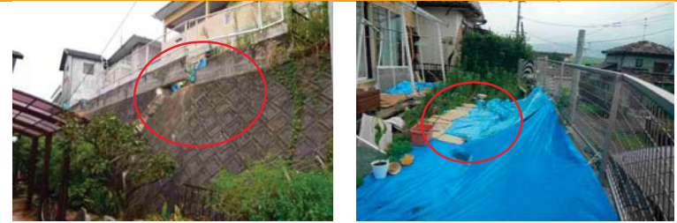
(a) 練石積擁壁の縦クラック(益城町) (b) 擁壁の上部宅地地盤の沈下(益城町)
