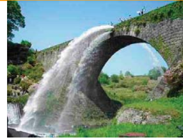
(a) 地震前の放水状況
