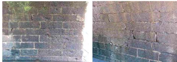
(a) 銭瓶橋の亀裂状況
