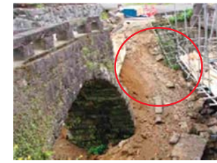
(b) 地震後の右岸側壁石崩壊状況
