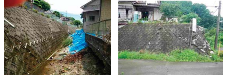
(c) 練石積擁壁の横クラック(益城町) (d) 練石積擁壁のコーナー部の崩壊(益城町)
