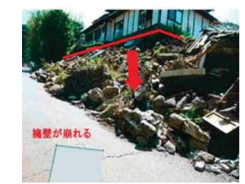
(l) 空石積擁壁の崩壊
