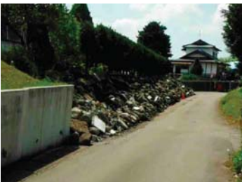
(g) 空石積擁壁の崩壊(西原町)
