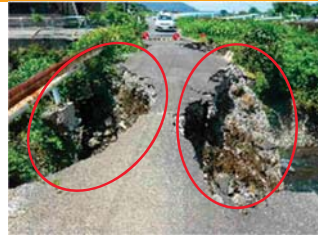
(b) 上下流壁石の崩壊状況
