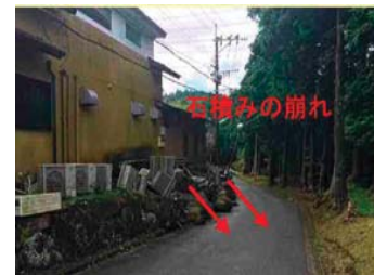
(i) 練石積擁壁の倒壊
