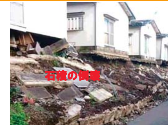
(j) 練石積擁壁の倒壊
