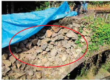
石材の中詰め
