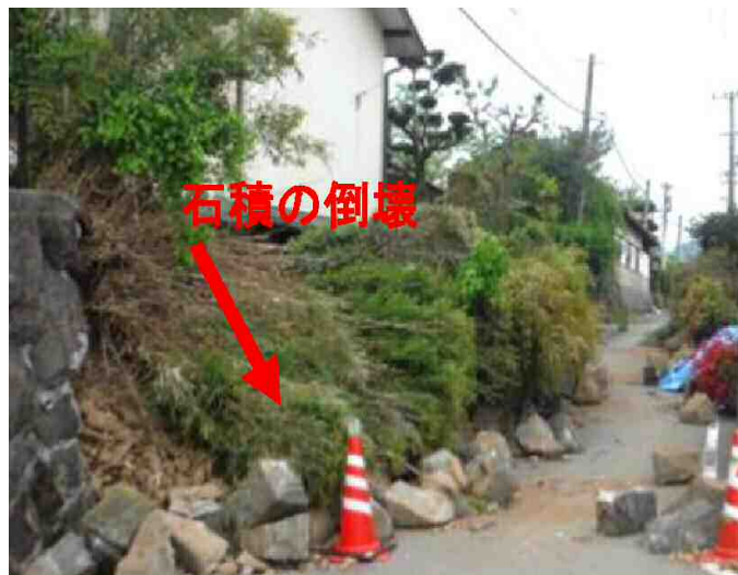
(k) 空石積擁壁の崩壊
