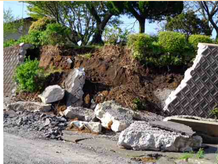
(f) 練石積擁壁の倒壊 (南阿蘇村)
