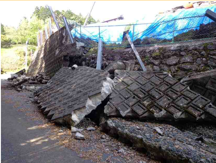
(e) 練石積擁壁の倒壊 (西原町)
