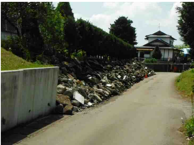
(g) 空石積擁壁の崩壊 (西原町)
