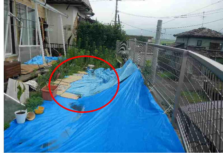
(a) 練石積擁壁の縦クラック (益城町) (b) 擁壁の上部宅地地盤の沈下 (益城町)
