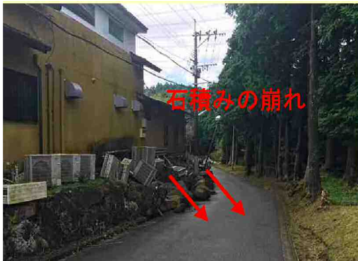
(i) 練石積擁壁の倒壊
