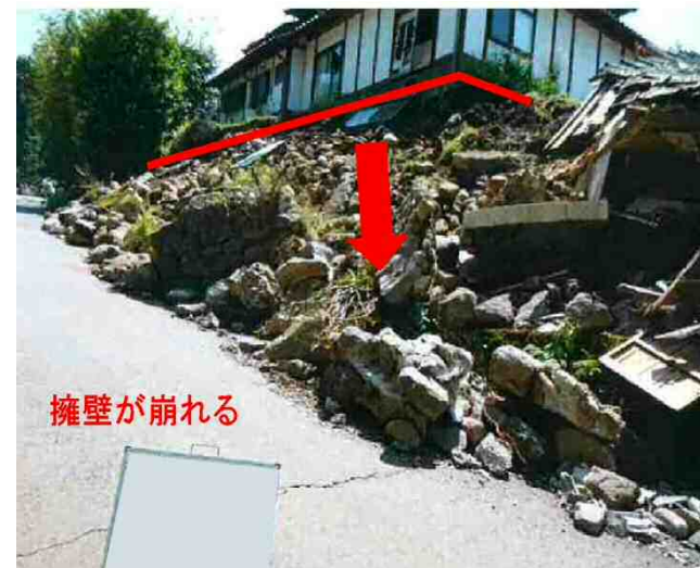
(l) 空石積擁壁の崩壊
