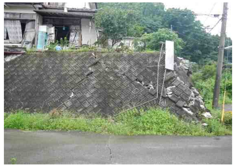
(c) 練石積擁壁の横クラック (益城町) (d) 練石積擁壁のコーナー部の崩壊 (益城町)
