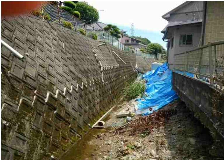
(c) 練石積擁壁の横クラック (益城町) (d) 練石積擁壁のコーナー部の崩壊 (益城町)
