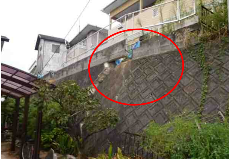
(a) 練石積擁壁の縦クラック (益城町) (b) 擁壁の上部宅地地盤の沈下 (益城町)
