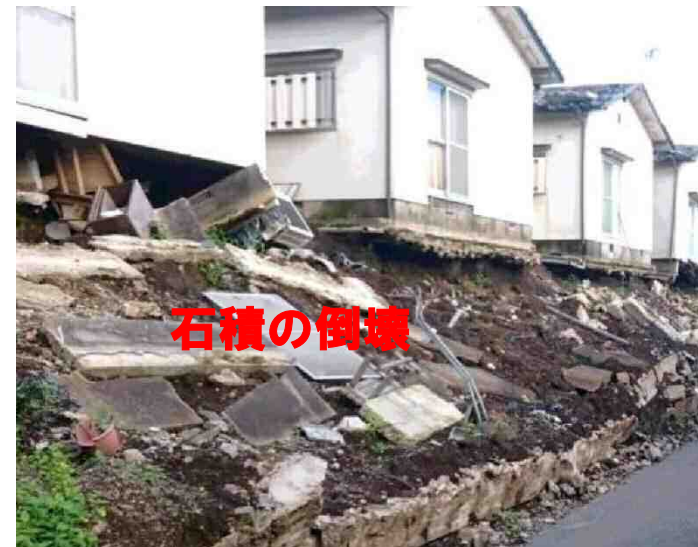
(j) 練石積擁壁の倒壊
