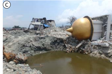
流動土塊の堆積部。モスクは何度も回転しながら 250m 流下し転倒 ( 流動地盤は盤状ではなかった )
