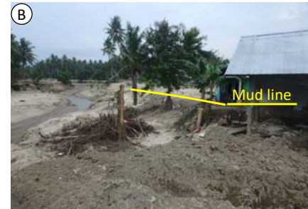
下流部では地震から10分後に洪水が押し寄せ、1時間続いた
