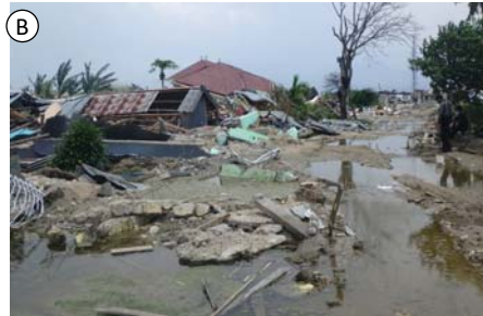
流動土塊の堆積部。地盤は大きく隆起するも、 至る所で湧水を確認
