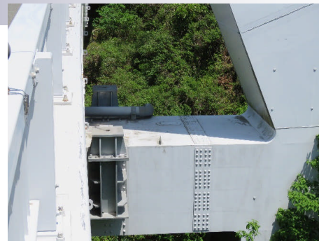
支間長が 短いA2橋 台側で浮き 上がり
