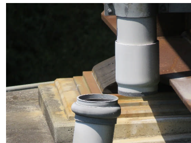
積層ゴム系支承が破 断していないP2橋脚
