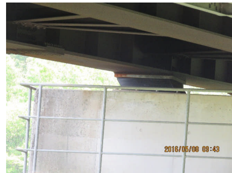
中間橋脚上積層ゴム支承変形
