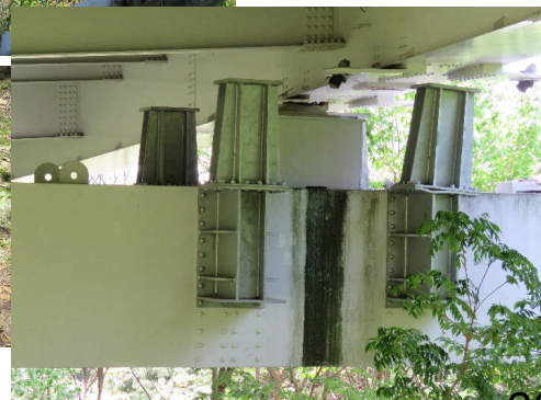
支間長が 短いA2橋 台側で浮き 上がり
