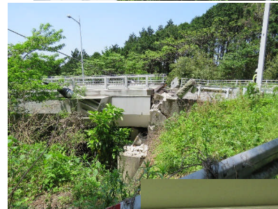
支間長が 短いA2橋 台側で浮き 上がり
