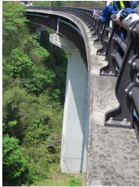
積層ゴム系支承が破 断していないP2橋脚
