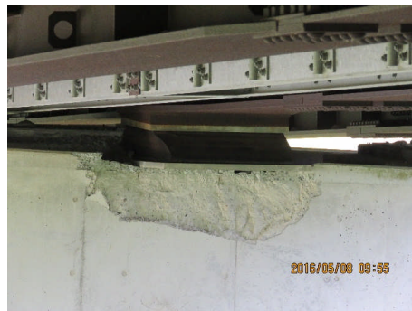
中間橋脚上積層ゴム支承変形
