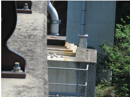
P1橋脚と積層 ゴム系支承
