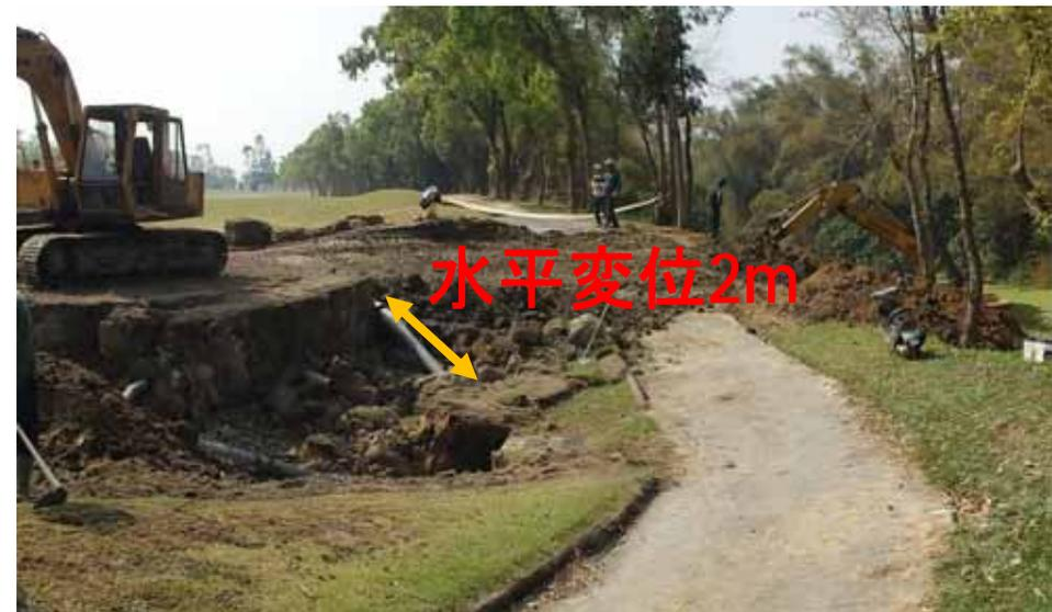
地震発生(3:57AM)後、3~4時間後(7~8AM)に変状発見。変状は12PMごろ収束
