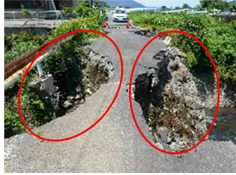
(b) 上下流壁石の崩壊状況
