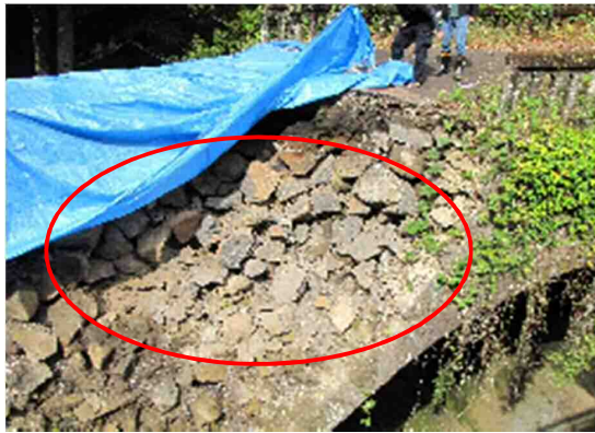
石材のみの中詰め
