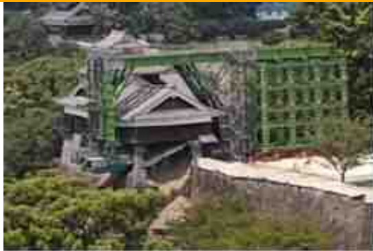
飯田丸櫓台石垣(隅石の算木積みは健全)
