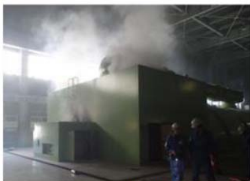
タービン出火状況
