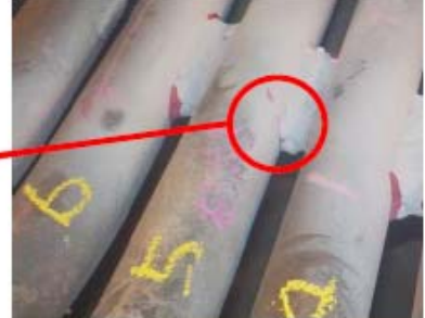
火炉下部パス管(缶右)損傷
