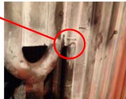
ケージ側部管右側損傷
