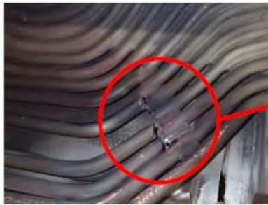
火炉下部パス管(缶左)損傷
