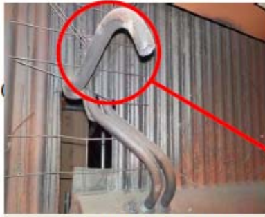
火炉出口部側壁管(缶左)損傷
