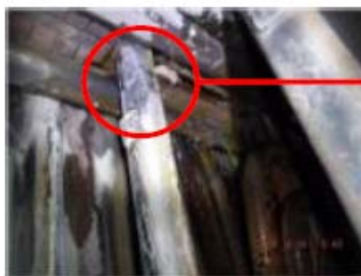
水冷壁側部管左側損傷
