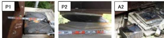
写真-5 各下部構造で異なるゴム支承の破壊形態(大切畑大橋)
