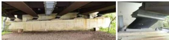
写真-4 ゴム支承の残留変形(扇の坂橋A1橋台)
