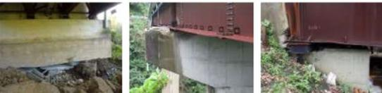
写真-1 橋台の沈下 (俵山大橋A1橋脚) 写真-2 ゴム支承の破壊 (俵山大橋P2橋脚) 写真-3 パラベット・ゴム支承の破壊 (俵山大橋A2橋台)
