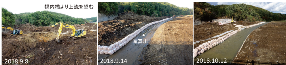
写真 6.2-2 堆積土砂の撤去状況（いずれも幌内橋から同じアングルで撮影）
