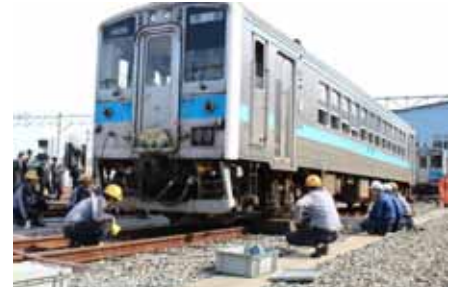
脱線車両の復旧
