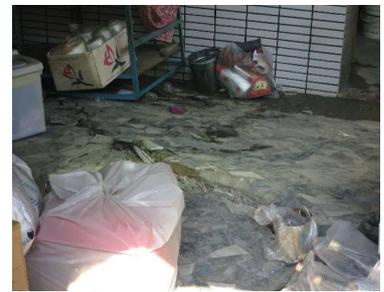
写真 屋内の床下で発生した地盤変形
