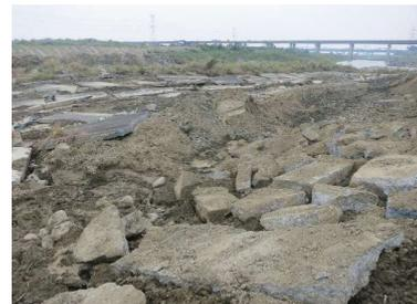
写真 堤防の土砂とともに滑り、散らばるコンクリートのり覆工
