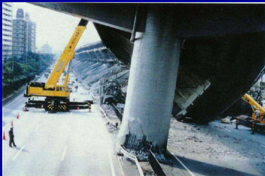
脆弱で崩壊した橋脚と、粘りを示した橋脚
