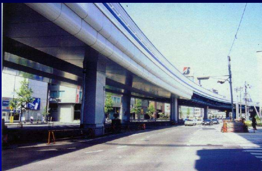
阪神高速3号線 弁天工区の橋脚下端免震による改築
