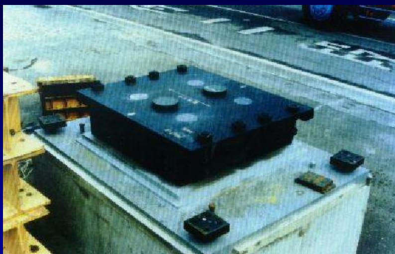
弁天工区の橋脚下端に設置された免震支承（LRB）
