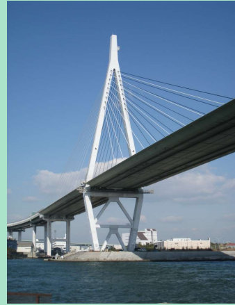
改修後の天王山大橋
