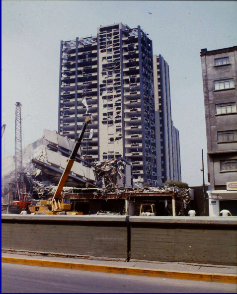
倒壊した20階 鉄鋼ビル
