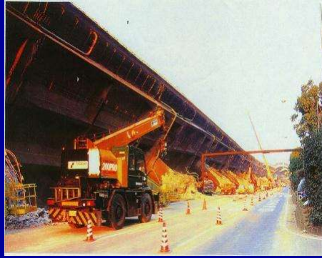
兵庫県南部地震(1995)により崩壊した 阪神高速道路3号線ピルツ型高架橋
