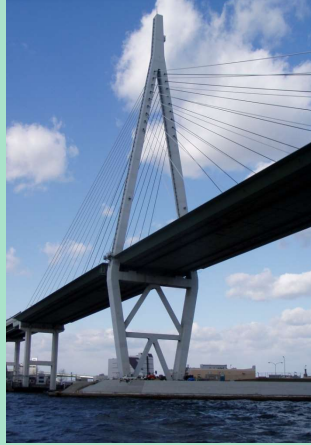
改修前の天保山大橋
