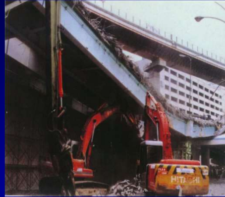
阪神高速3号 弁天工区に於ける 桁一柱合結高架橋の崩壊
