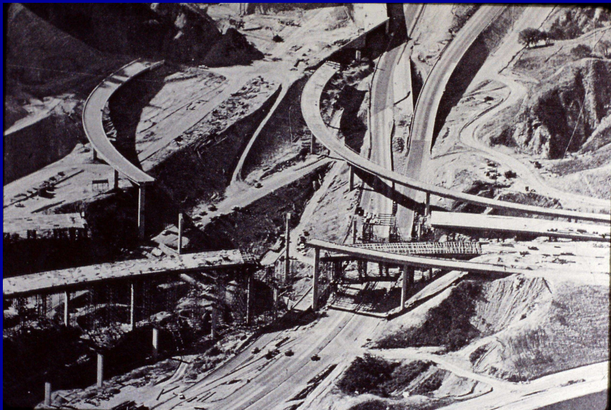
倒壊した高橋脚曲線高架高速道路
