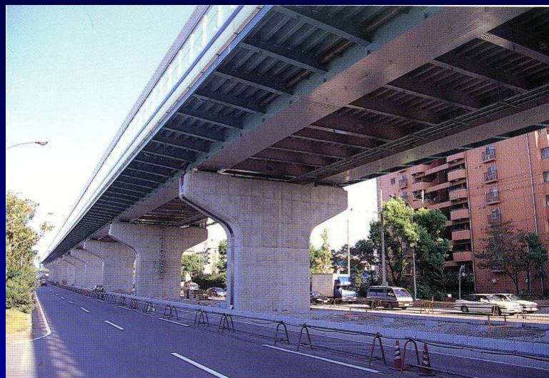
阪神高速3号線 ピルツエ区の免震改築
