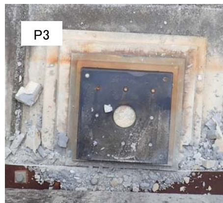
支承取付ボルト部で損傷
