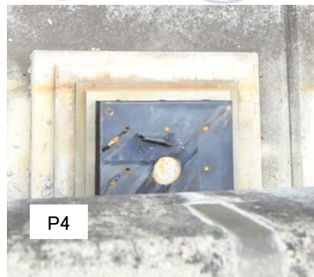
支承取付ボルト部で損傷
