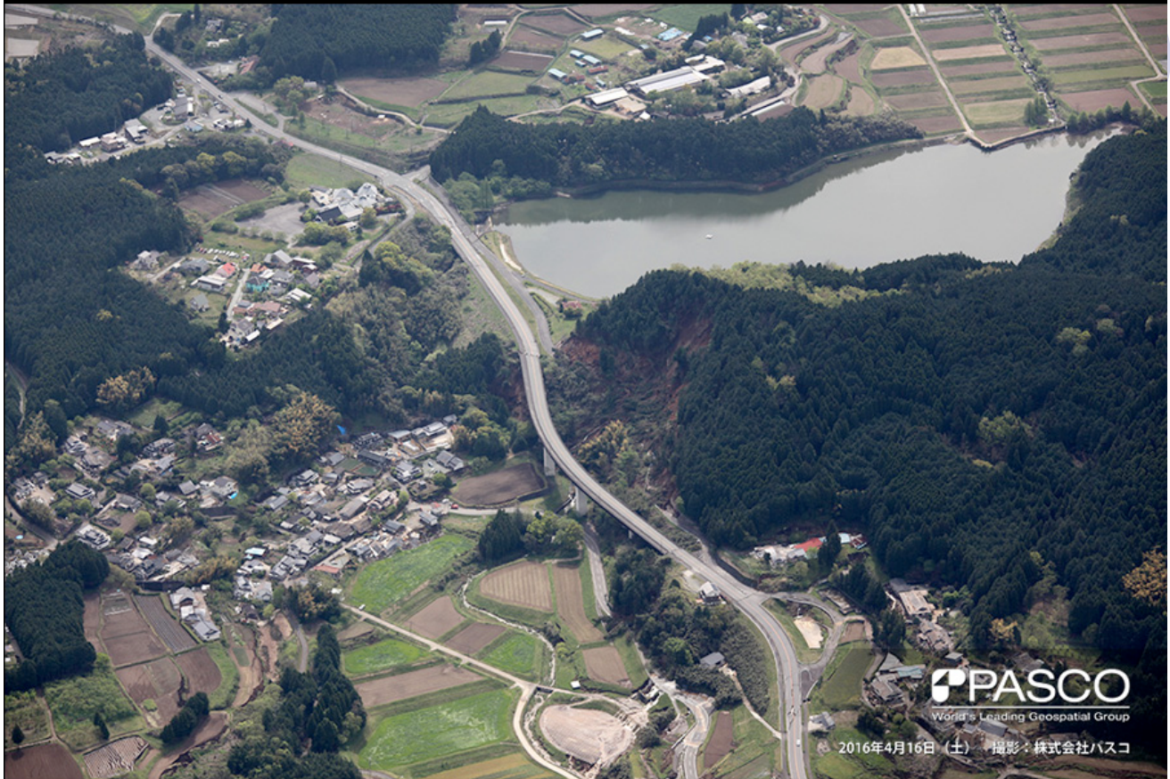
西原村大切畑地区。大切畑ダム近くで斜面崩壊が発生している。
