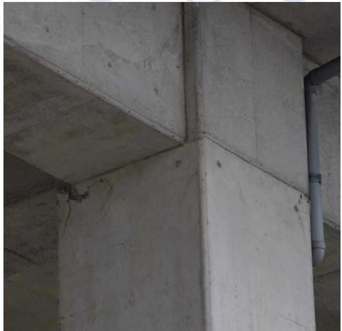
高架橋柱上部に軽度な曲げひび割れ
