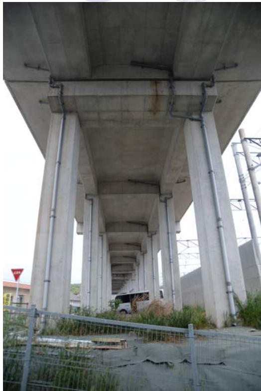
高架橋柱上部に軽度な曲げひび割れ
