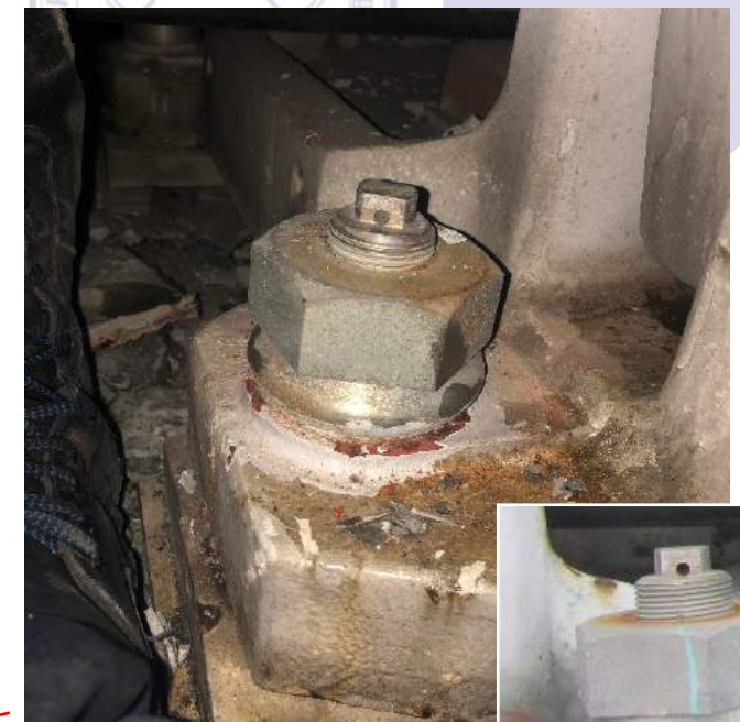
支承 アンカーボルト 緩衝材の変形 健全な状態
