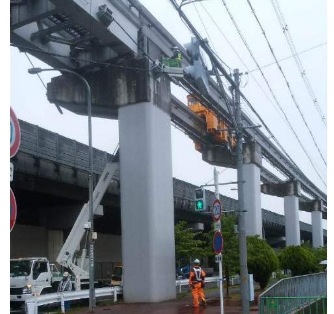
軌道点検状況
