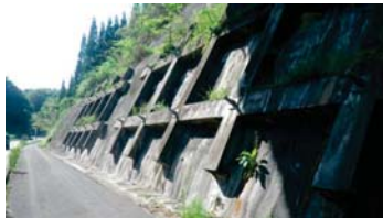
グラウンドアンカー工: 異常無し (国道445号)
