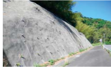
健全な状態を維持した切土補強のり面 (国道445号)
