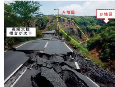
村道筋の木立野線(長陽大橋付近)の被災のり面対策工
