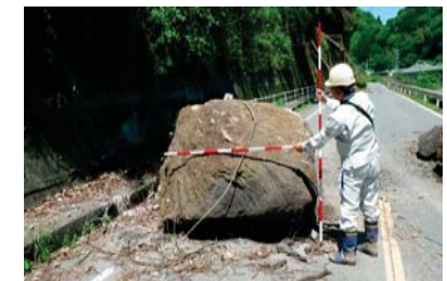
落石防護柵を飛び越えて道路に達した落石 (上益城郡御船町下鶴 国道445号)
