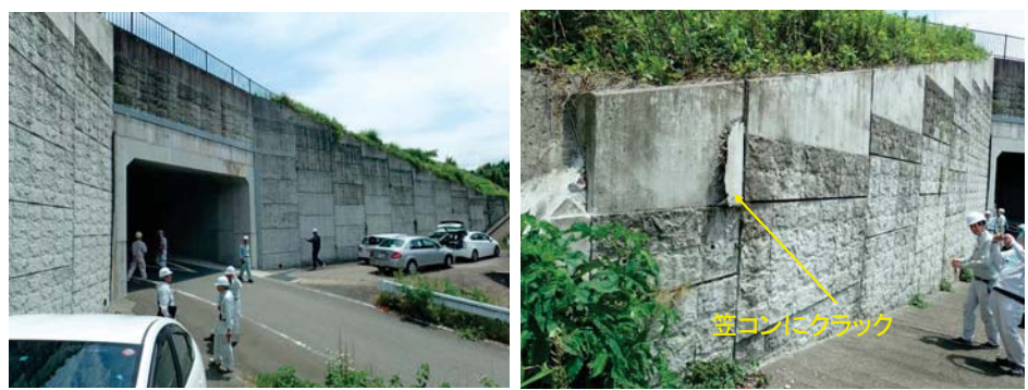
国道57号線(立野地区)の補強土壁・ボックスカルバート
