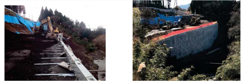
県道149号線補強土壁の復旧状況 (左:補強材敷設2017.12.11撮影, 右:盛土構築2018.1.26撮影)
