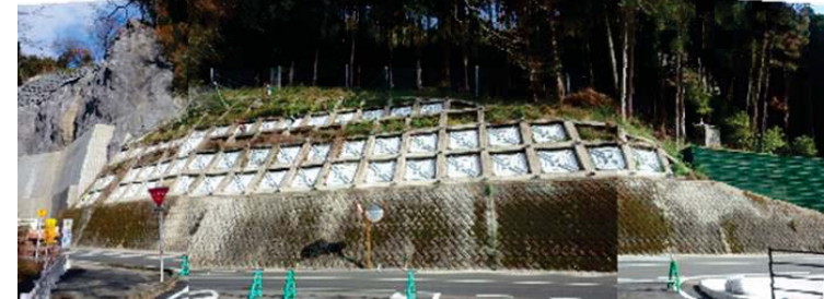
村道栃ノ木立野線のり面(B地区)の復旧状況, 2017.12.11撮影
