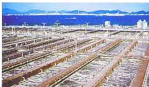
下水道の整備
