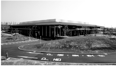
名古屋市立第2斎場 火葬炉30基 平成27年度供用開始
