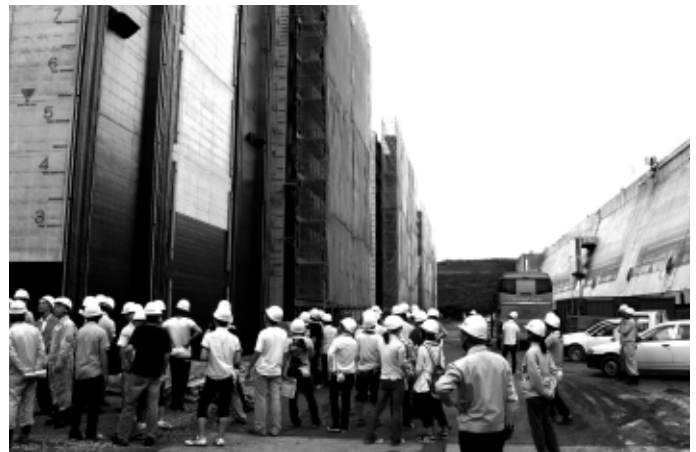
100万人の市民現場見学会 大学生を対象にした「衣浦港3号地廃棄物最終処分場整備事業・護岸工事」 (護岸に利用するケーソンの製作現場)の見学会 (提供・日本土木工業協会)
