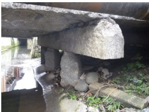
供用中の石桁橋
