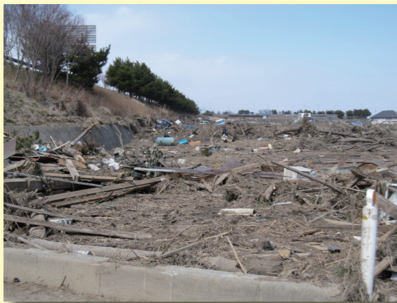
津波を止めた仙台東部道路（宮城県）
