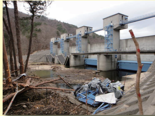
津波の遡上を防いだ普代水門（岩手県）
