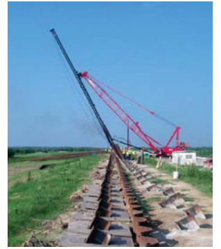
【Hパイル打設】
