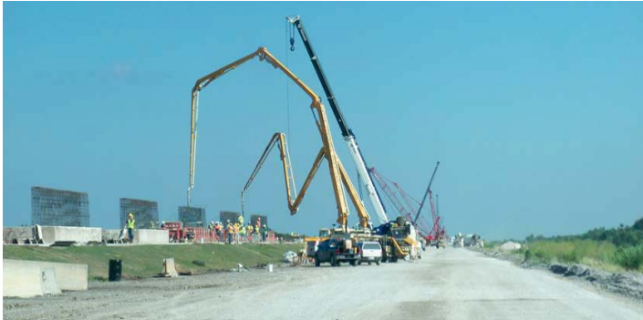
【逆T字擁壁構築】
