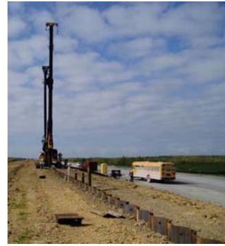
【シートパイル打設】
