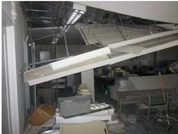
図 8：空港ビル 3 階事務所室内の被災状況（仙台空港ビル㈱提供）
