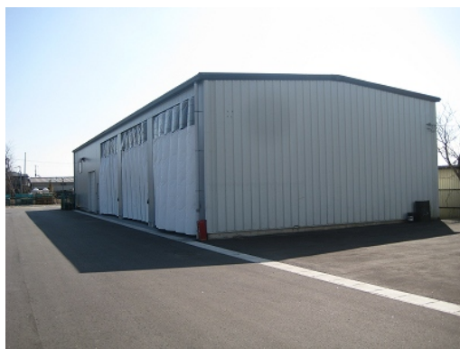
保管倉庫の整備
