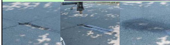
図3.8 ポットホールの機械化施工
