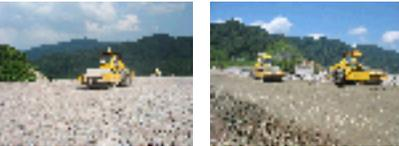
新技術によるデータ取得状況(振動ローラにて施工を行いながらデータ取得)
