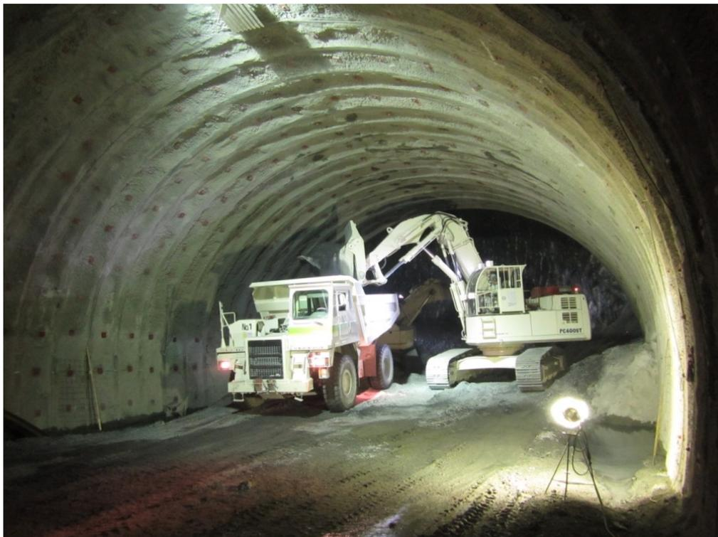
トンネル掘削状況（掘削土の積込搬出）
