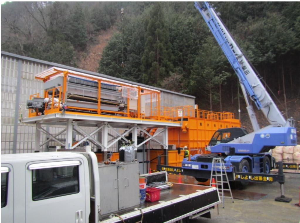
準備工事状況（濁水処理プラント設置）
