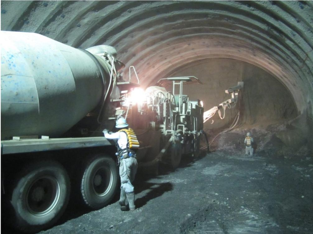
トンネル掘削状況（吹付コンクリート施工）
