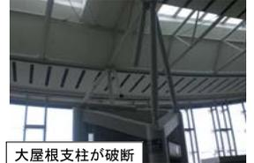
大屋根支柱が破断
