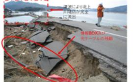
津波により国道45号田沼陸路側の埋込み型光ケーブルが流出
