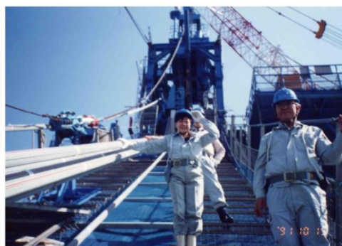
明石架橋 ケーブル足場
