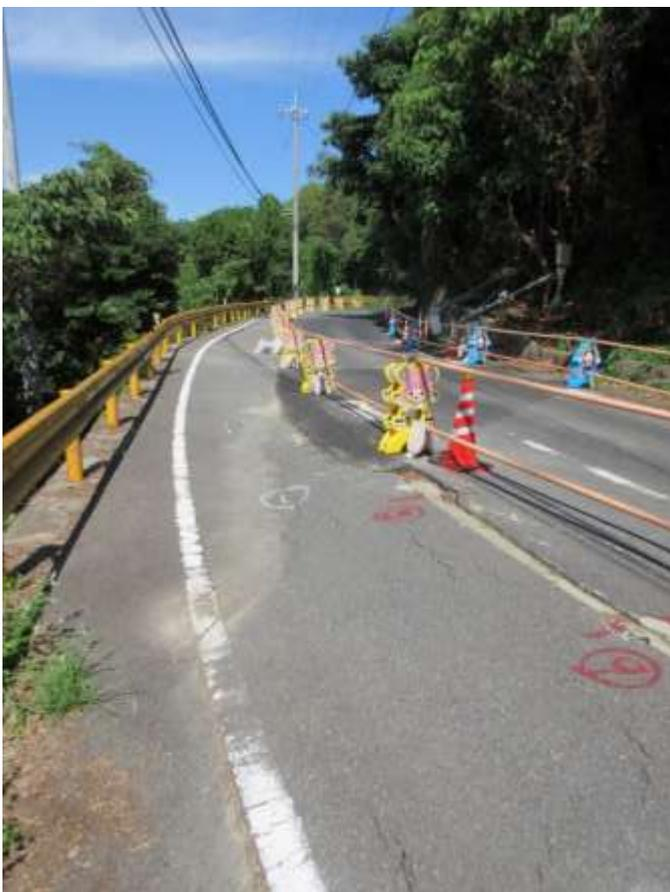
特に、左側の車線部が左斜め下方に数十センチ移動し、クラックが発生。
