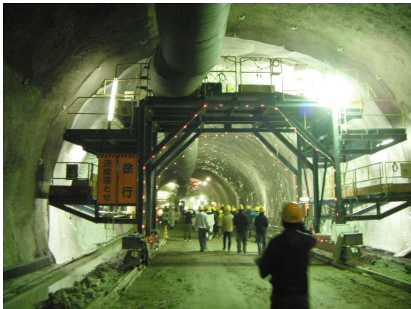
写真: 東広島呉道路 「岩山トンネル」
