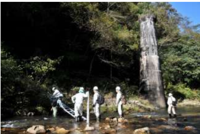
写真-2 有福第四トンネルの踏査にむけて下府川を渡る
