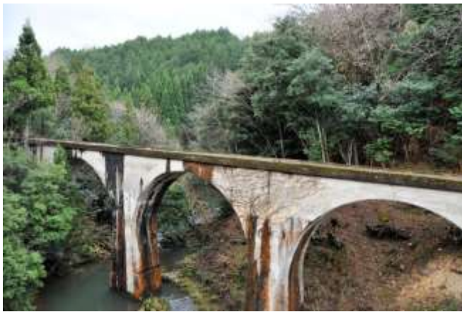
写真-1 選奨土木遺産のコンクリートアーチ橋
