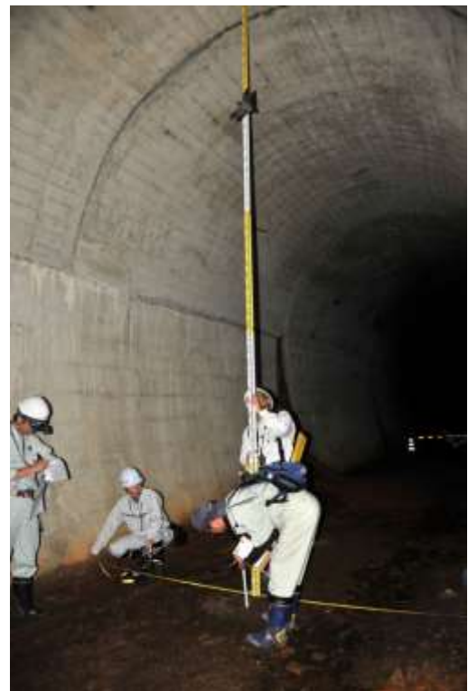
写真-3 トンネル断面の計測
