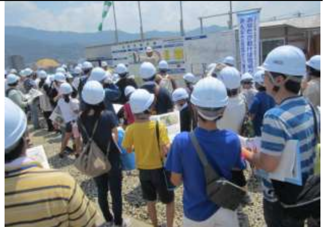
工事概要の説明
