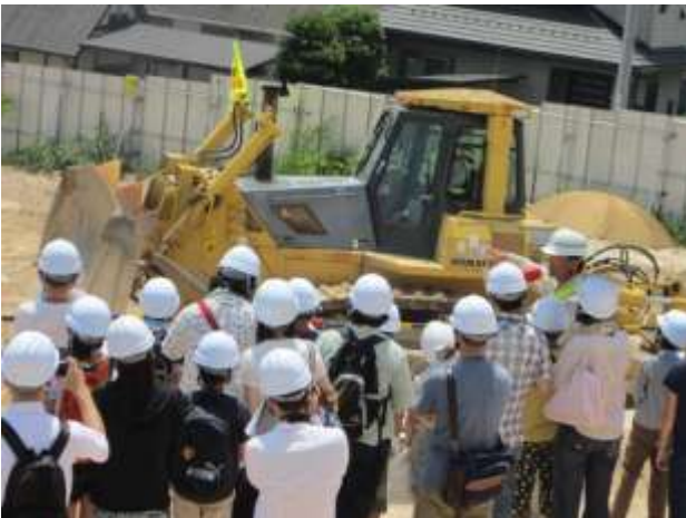
ブルドーザ掘削実演
